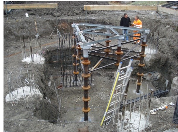
Fundamentkorb mit schwimmenden Pfählen (Ø 120cm, 10m)
